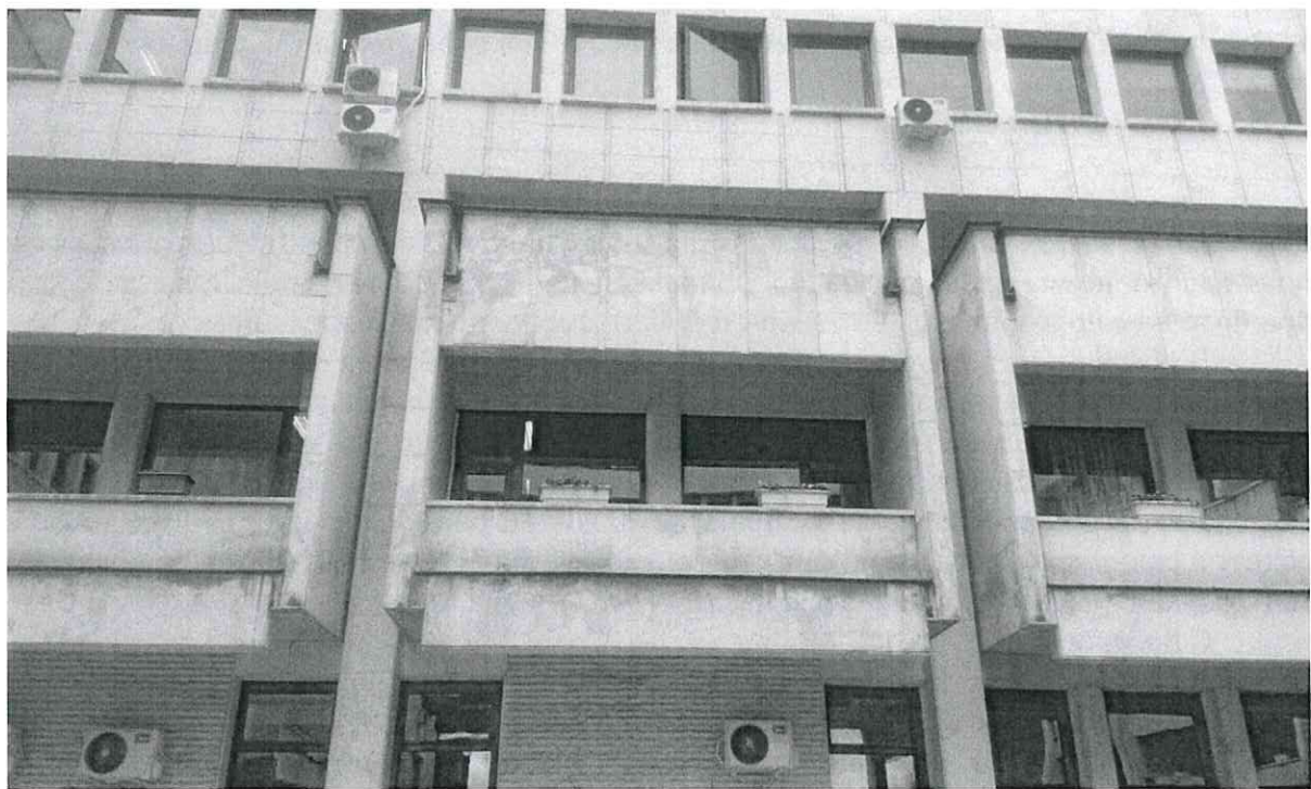
С оглед на това се налага ремонт на съществуващата облицовка.
